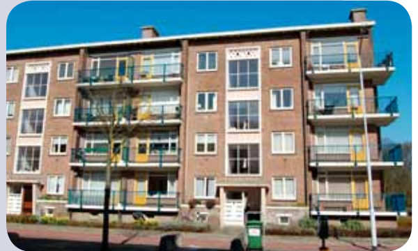
Het complex aan de Bruijnings Ingenhoeslaan, voordat de werkzaamheden begonnen.
